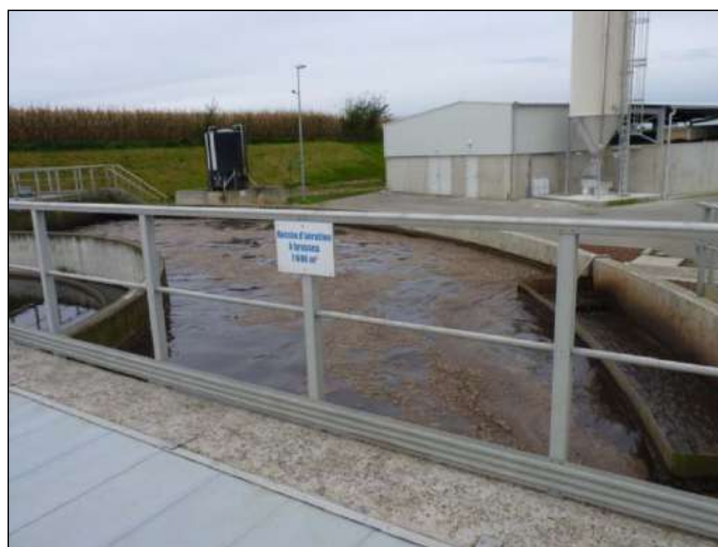
Photo 2: Station d'épuration de Rosières-en-Santerre (novembre 2013)
